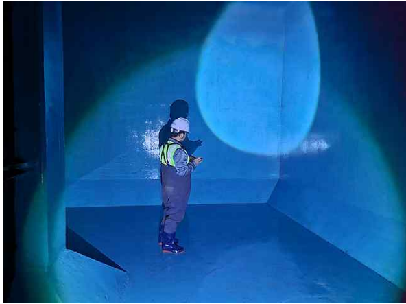
<내부 개별부재 외관조사>
