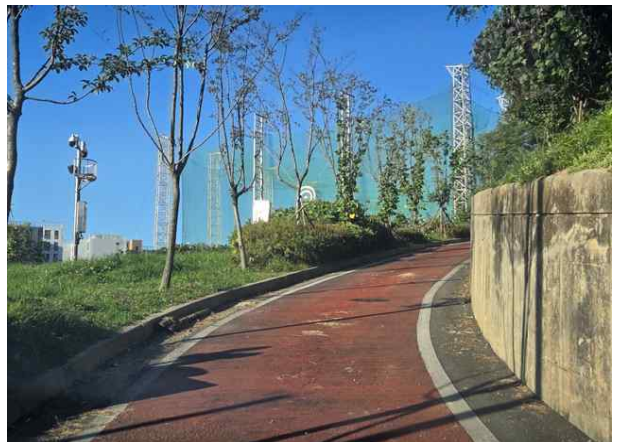
<진입도로 포장 전경>
