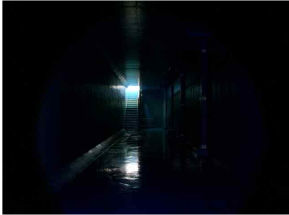
<배수지 1지 전경>
