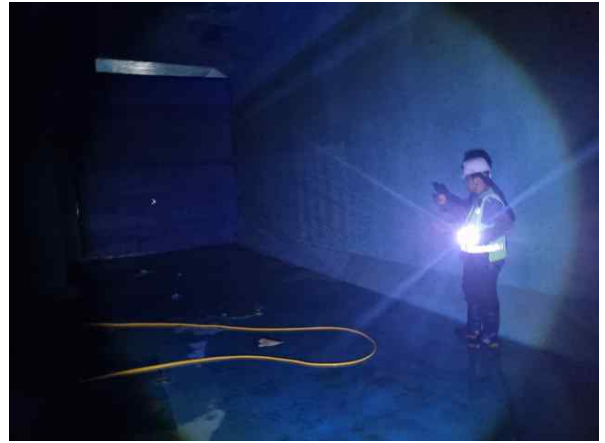
<내부 개별부재 외관조사>
