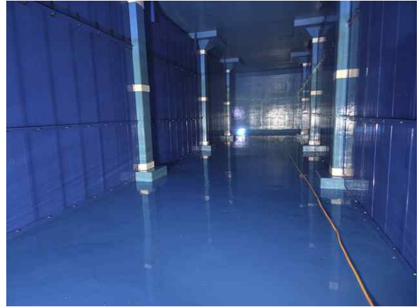
<배수지 2지 전경>
